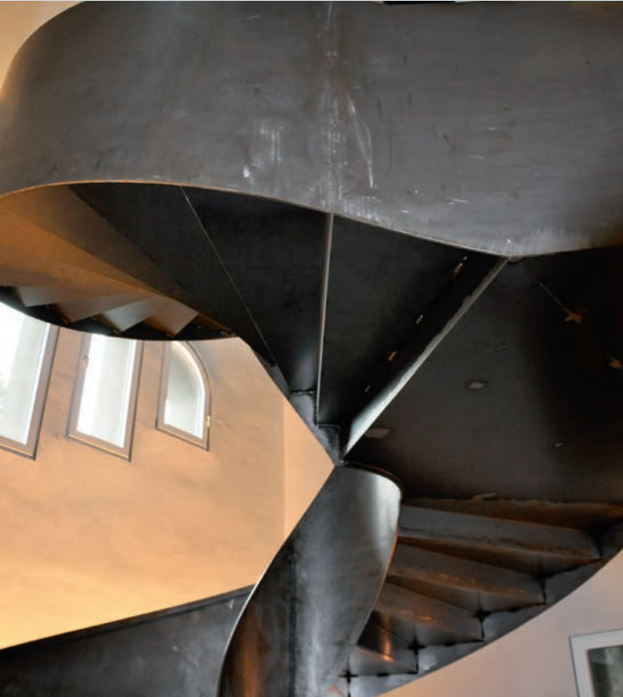
Die neue, komplett aus Stahl gefertigte Innentreppe erschliesst zwei Geschosse und weist eine Gesamthöhe von rund 8 m auf. Le nouvel escalier intérieur entièrement en acier débouche sur deux étages et présente une hauteur totale d'environ 8 m.
