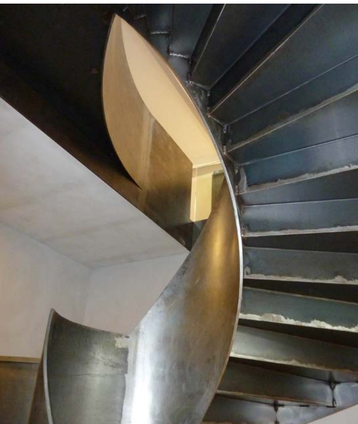
Der innere Wendel aus Stahlblech 15 mm weist naturgemäss eine hohe Eigensteifigkeit aus. Hier wurde bei der schweisstechnischen Fertigung besonders darauf geachtet, die Eigenspannungen möglichst tief zu halten und diese über den gesamten Querschnitt gleichmässig zu verteilen. Le limon hélicoïdal intérieur en tôle d'acier de 15 mm présente naturellement une rigidité intrinsèque élevée. Sur le plan de la technique de soudage, les concepteurs ont veillé à limiter le plus possible les contraintes résiduelles et à les répartir uniformément sur toute la section.
