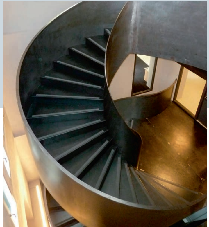
Der innere Treppenwendel (Stahlblech 15 mm) erzeugt am Fusspunkt der Treppe eine Druckkraft von 157 kN nach unten. Der äussere Wendel (Stahlblech 10 mm) hingegen, eine Zugkraft von 21 kN nach oben. Le limon hélicoïdal intérieur de l'escalier (tôle d'acier de 15 mm) génère au pied de l'escalier une force de compression de 157 kN vers le bas, contre 21 kN vers le haut pour le limon hélicoïdal extérieur (tôle d'acier de 10 mm).
