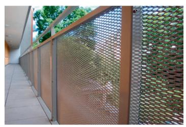
Gut zu erkennen, die Ausrichtung der Maschen und der erzeugte Winkel der freigegebenen Durchsicht.
