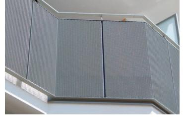
Oben und unten sind die Streckmetalle in Traversenprofilen aus Winkelstahl gefasst. En haut et en bas, les tôles en métal déployé sont enchâssées dans des profilés de traverses en cornière d'acier.
