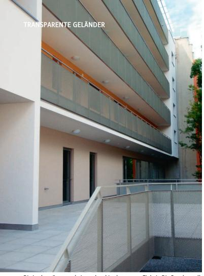
Die Laubengänge erscheinen als ruhige homogene Einheit. Die Streckmetallbrüstungen sind bis zur Unterkante des Betonbodens geführt.
