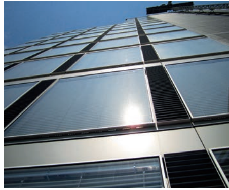
Ansicht Aussenhülle Aperçu de l'enveloppe extérieure
