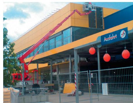
Ein Blech nach dem anderen wird an den Zielort gehievt, eingehängt und gesichert.
