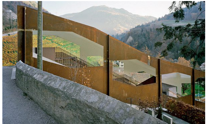
Austritt oben. 12 mm starke, verschweisste Stahlbleche grenzen den Weg ein. L'arrivée supérieure. Des tôles d'acier soudées de 12 mm d'épaisseur délimitent le chemin.
