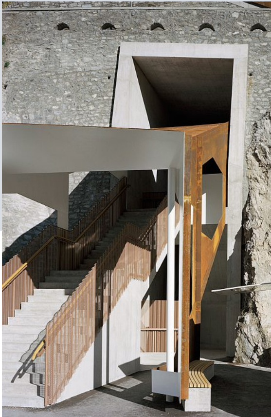
Das Dach ist als Kastenkonstruktion ausgeführt. Le toit est réalisé sous forme de construction modulaire.
