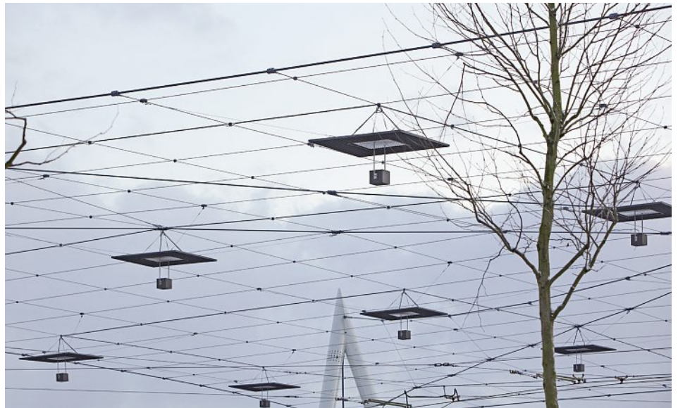
Elegant gelöst: die Platzbeleuchtung über eine Fläche von 60 × 60 Meter.
