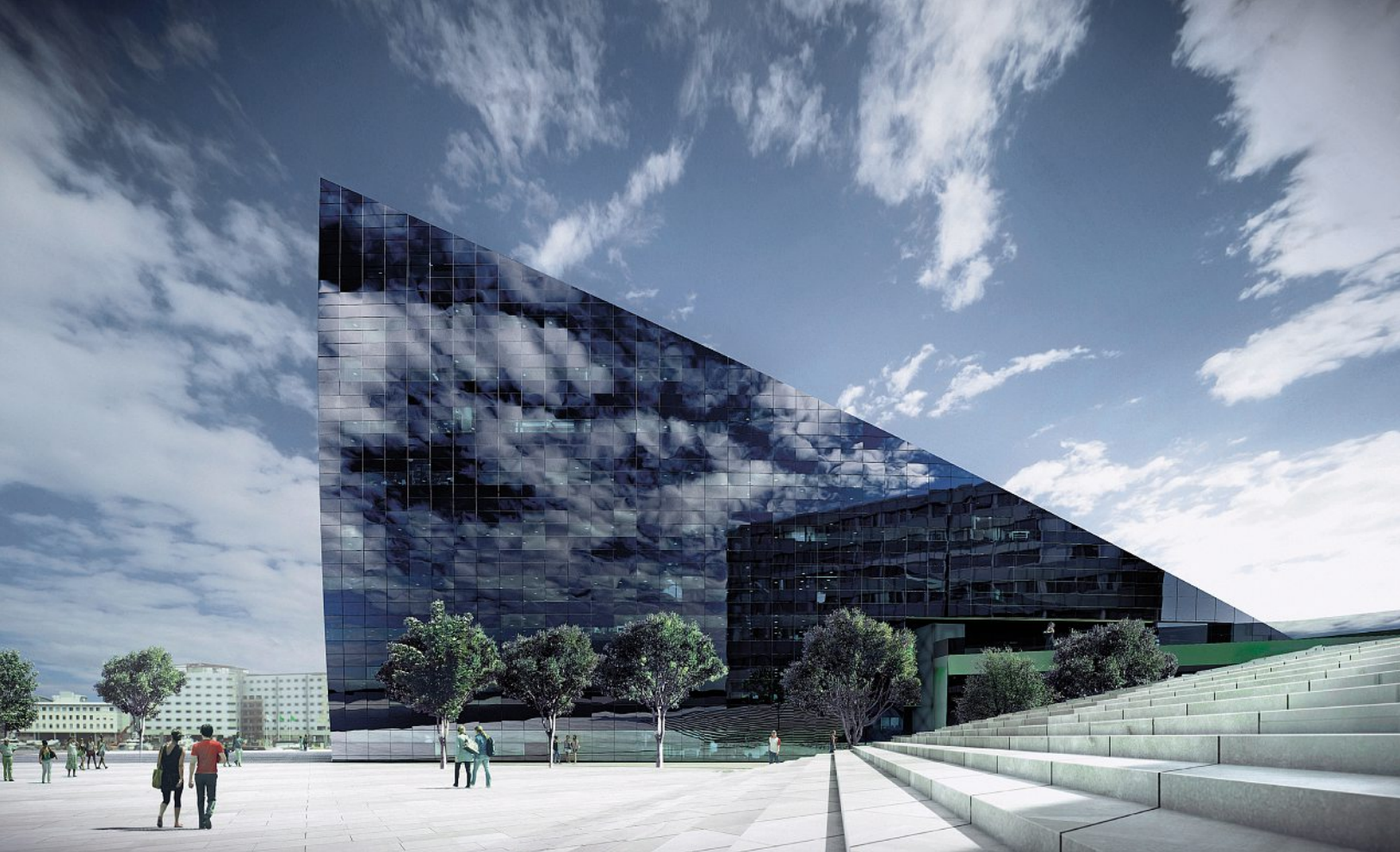
Transparente Fensterbereiche und gebäudeintegrierte Photovoltaikpaneele bilden zusammen eine homogene, glatte Aussenhaut.
