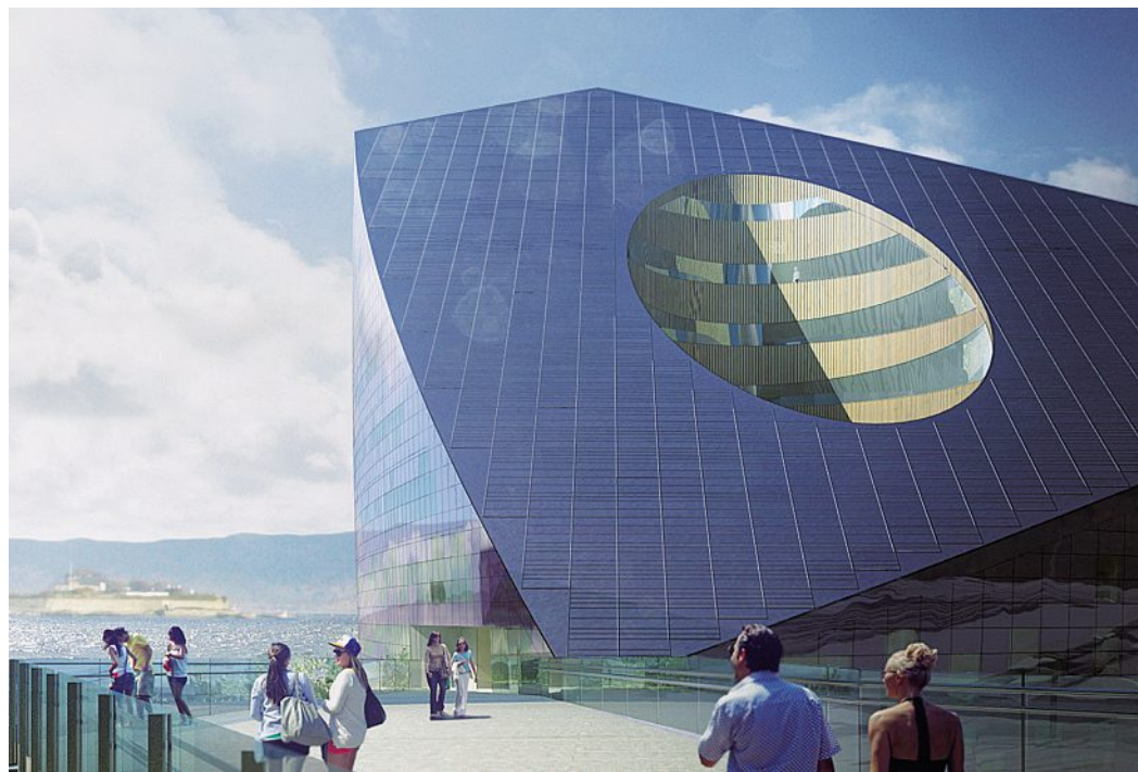
Die nach Süden geneigte Dachfläche aus Photovoltaikpaneelen wird vom zylinderförmigen Atrium durchbrochen.
