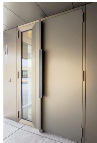
Flügel, Rahmen und Wandverkleidung sind flächenbündig ausgeführt. Les battants, cadres et revêtements muraux sont à fleur.
