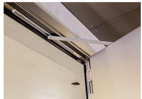
Elegant im EI30-Profil versenkt – der integrierte Türschliesser (mit Schliessfolgeregelung bei Doppelflügeltüren).
