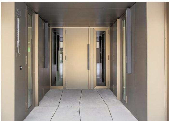
Edel wirken die Aluminium-Brandschutztüren mit der speziellen Oberflächenbehandlung geschliffen, gebürstet und im Permalux-Verfahren farbig anodisiert.
