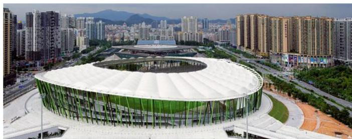
und radialen Speichen gewählt. Das Dach wird durch 36 radiale Seilpaare gebildet, deren Vorspannung über einen doppelten Zugring aus Litzenbündeln über dem Spielfeld
