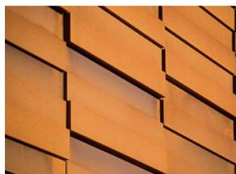
wurde bei der Planung auf die Sicherheitsanforderungen der Anlage gelegt. Markant präsentiert sich die Fassade im wetterfesten Cortenstahl mit seiner charakteristischen Oberfläche. Die Gebäude scheinen fast über der Oberfläche zu schweben, da sie elegant auf einem «Podest» aus grasbewachsenen Hügeln stehen. ■
