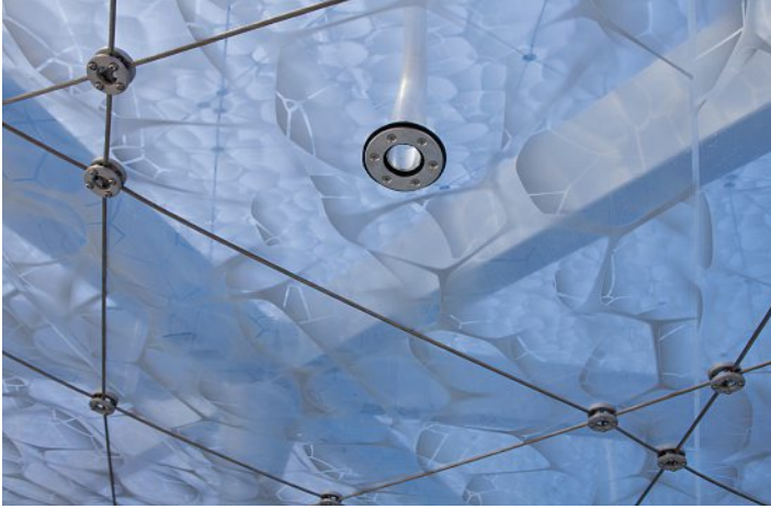
Die Planer entschieden sich für eine «chaotische» Seilführung. Les planificateurs ont opté pour un tracé de câbles désordonné.
