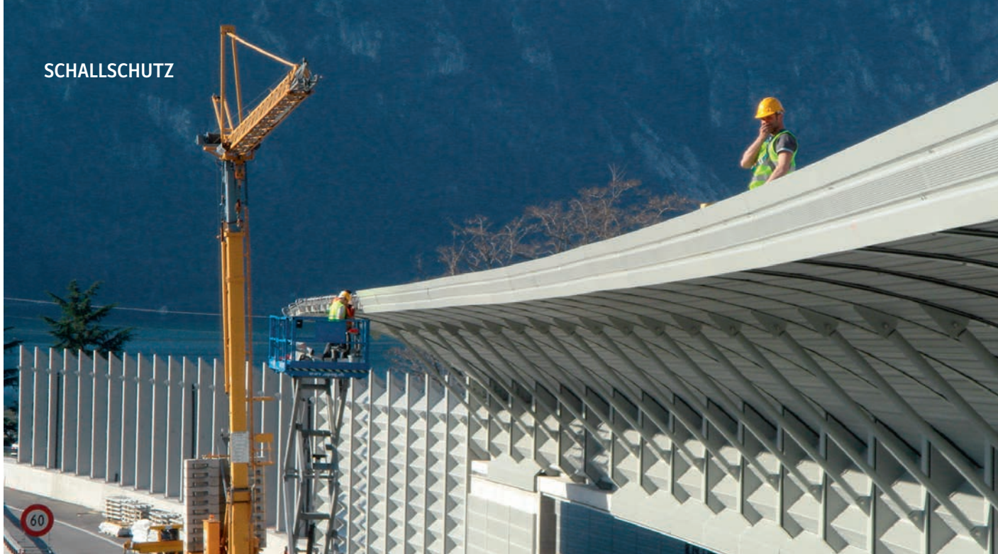
Montage talseitige Wand Montaggio della parete a valle
