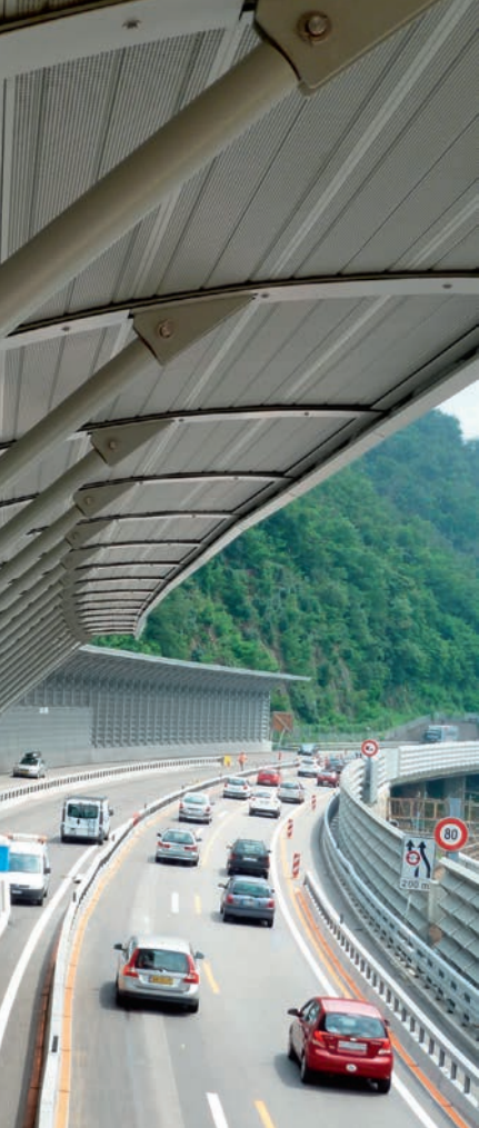
Lärmschutzeinrichtungen Autobahn Melide - Bissone
