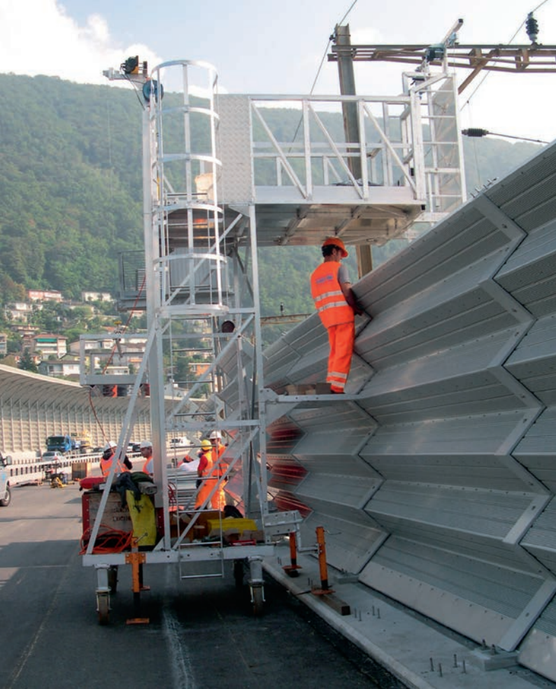
Montage Zickzackpaneel Montaggio del pannello a zig-zag
