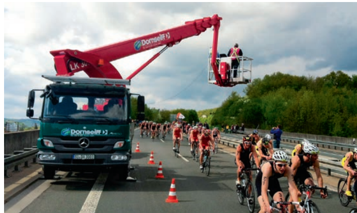
Auf der Radstrecke kam eine Lkw-Arbeitsbühne LK 300 mit 30 Meter Arbeitshöhe zum Einsatz.
