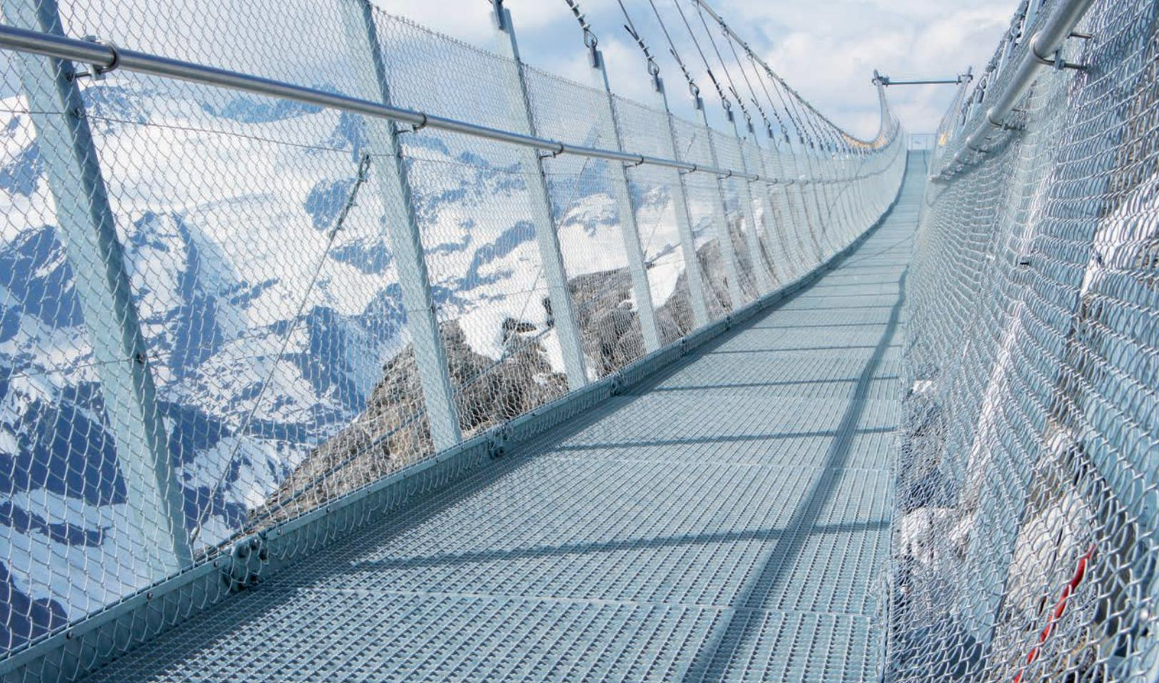
Boden und Banden sind so ausgeführt, dass möglichst kein Schnee hängen bleibt.
