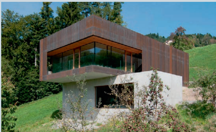
Das Wohnhaus ist mit korrodierenden Gitterrosten verkleidet. L'habitation est revêtue de caillebotis soumis à la corrosion.
