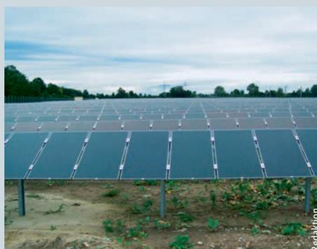
Modules solaires en tellure de cadmium (CdTe)
