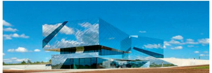
renden Gebäudehaut aus Aluminium-Verbundplatten von 4 mm Stärke bekleidet. Sie umhüllen das Gebäude vollständig und werden
