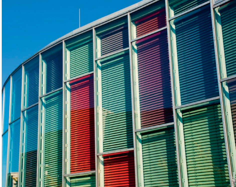
Sonnenschutz auf der Raumseite. Die Wärme dringt durch die Fassade, verhindert aber die direkte Bestrahlung von Personen und Infrastrukturen.
