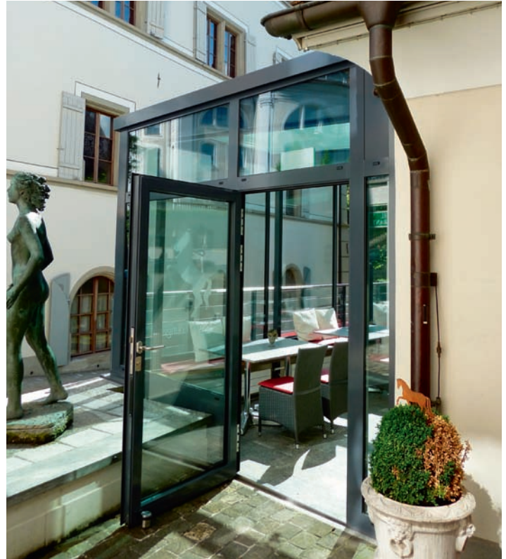
Der Zugangsbereich ist als herkömmliche, thermisch getrennte Türfront ausgebildet. L'accès intervient par une porte en façade classique, isolée thermiquement.
