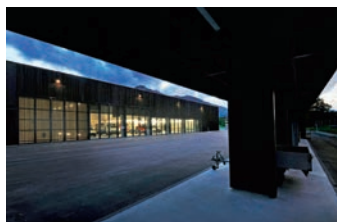
Der Gemeindewerkhof Balzers wurde mit Miko-Toren realisiert.
