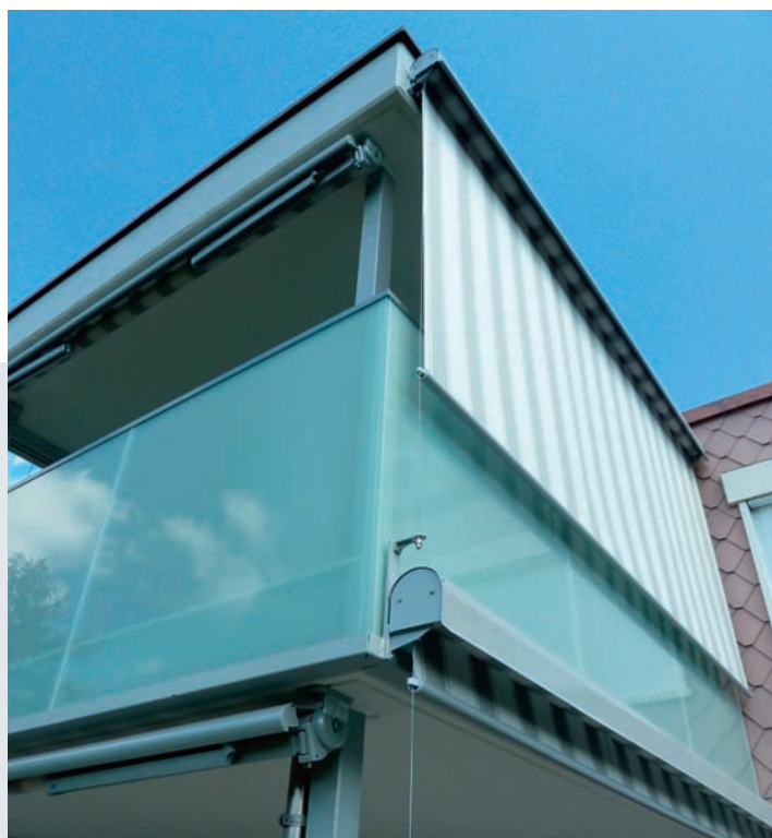
Der Glasmantel ist bis unter die Betonstirne geführt und strahlt so eine optische Ruhe aus. L'enveloppe vitrée couvre la dalle et donne une impression de sérénité visuelle.
