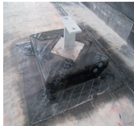
Einwandfreie Lösung: dicht abgeklebte Konsole Solution parfaite : console étanche par collage
