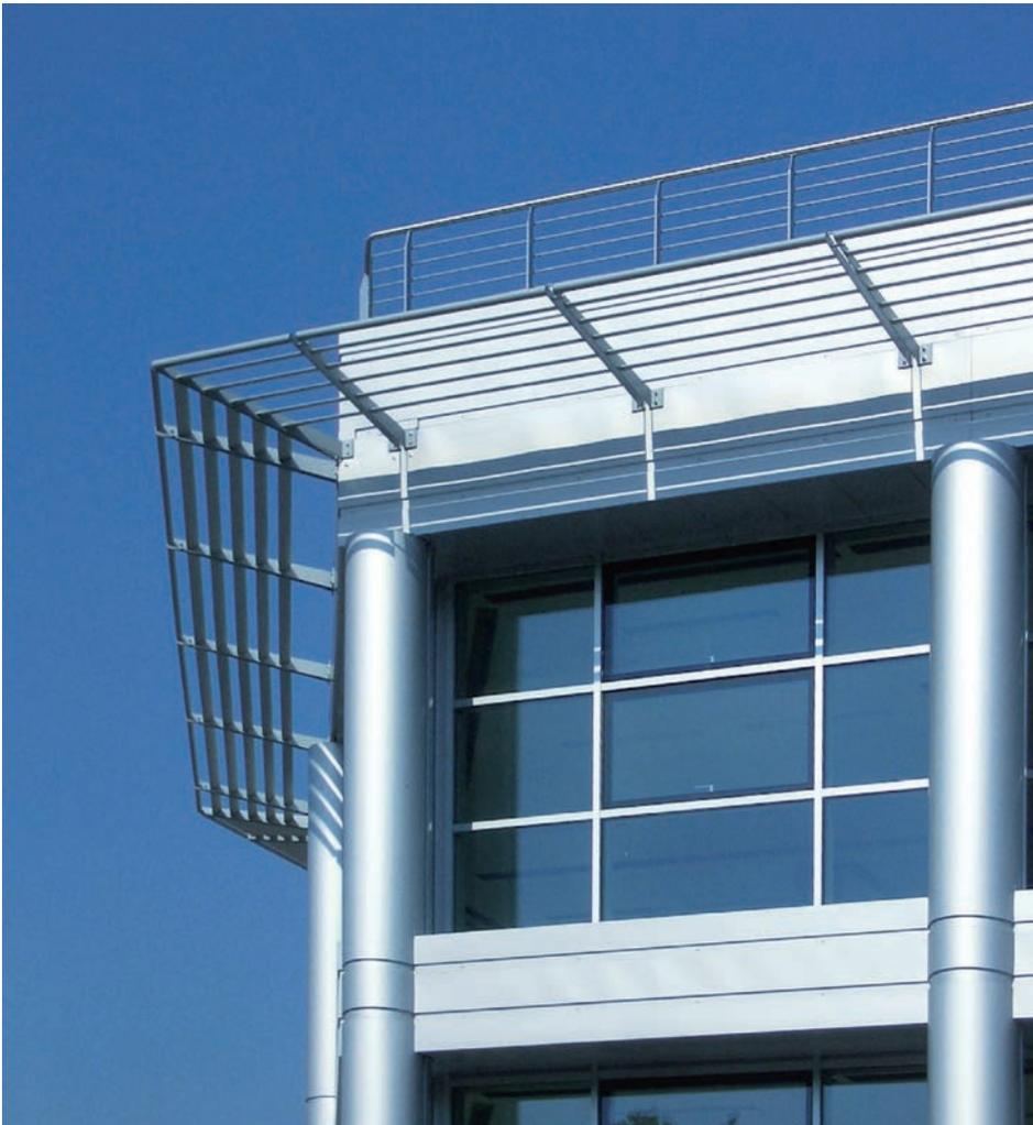
WICSOLAIRE Beschattungssysteme kontrollieren den Wärmeeintrag durch solare Strahlung und vermindern den Energiebedarf für Kühlung.
