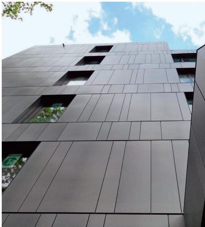
Die Oberflächen gewähren einen erhöhten schmutzabweisenden Korrosionsschutz, der absolut UV-beständig ist.
