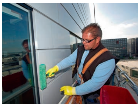
Vor Auftragserteilung sollte eine detaillierte Planung, eine Probereinigung mit der Aufnahme des Ist- und Soll-Zustandes und eine ausführliche Offerte zu Grunde liegen.
