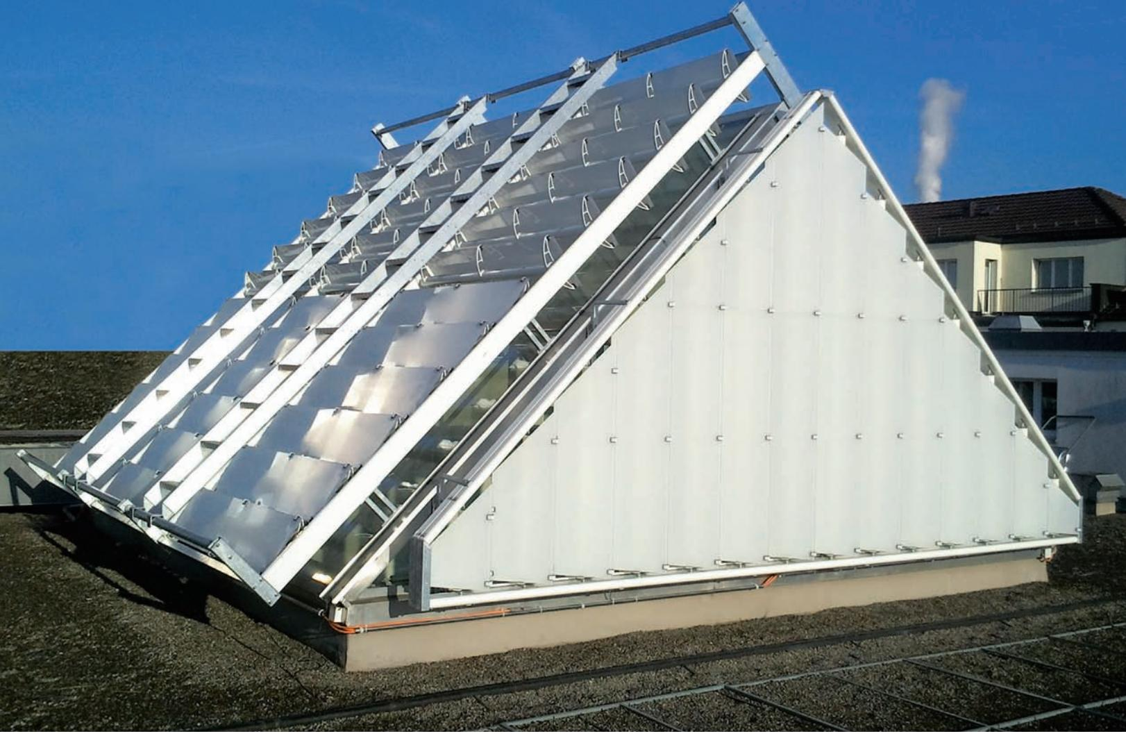
Eine vollautomatische Lamellen-Lichtlenkungsanlage sorgt in der WWF-Zentrale für eine effiziente Lichtverteilung.
