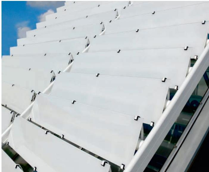
Auf der geneigten Südfront wurden die drehbaren Grosslamellen aus einem 12 mm starken, Licht reflektierenden Spezialglas (ESG / Opalika) horizontal angeordnet.
