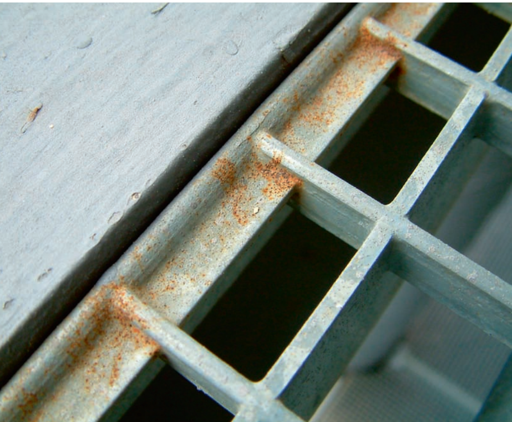
Die «Gelbfärbungen» wurden bei den Untersuchungen eindeutig als Fremdrost identifiziert. Les tests ont clairement révélé que les « jaunissements » sont dus à de la rouille erratique.
