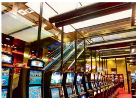
Durchblick von innen. Gut zu erkennen die Rauch-Abzugsvorrichtung. Vue de l'intérieur. Le dispositif d'extraction de fumée est bien visible.
