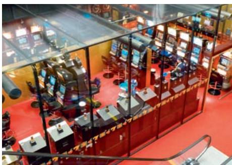
Der gläserne Kubus gewährt höchste Transparenz in alle Richtungen. Verglasung: Dach VSG 11-4 extraweiss. Front Front ESG 10 mm. Le cube de verre offre une transparence maximale, dans toutes les directions. Vitrage: couverture en verre de sécurité feuilleté 11-4 extrablanc. Façade en verre trempé de sécurité 10 mm.
