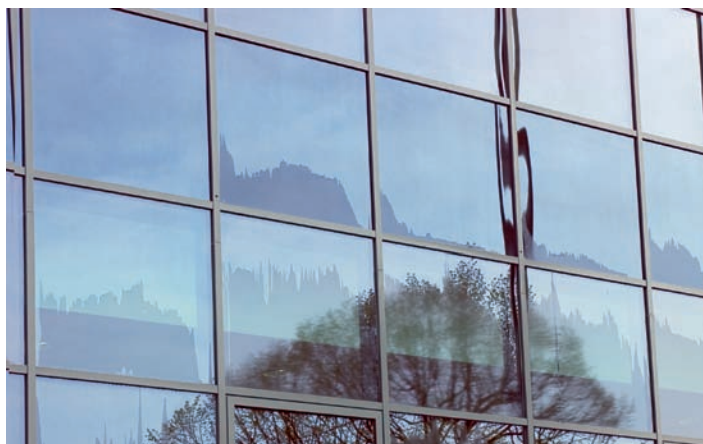
Deutlich bessere Durchsicht trotz Kondenswasser. Plus de transparence malgré l'eau de condensation.
