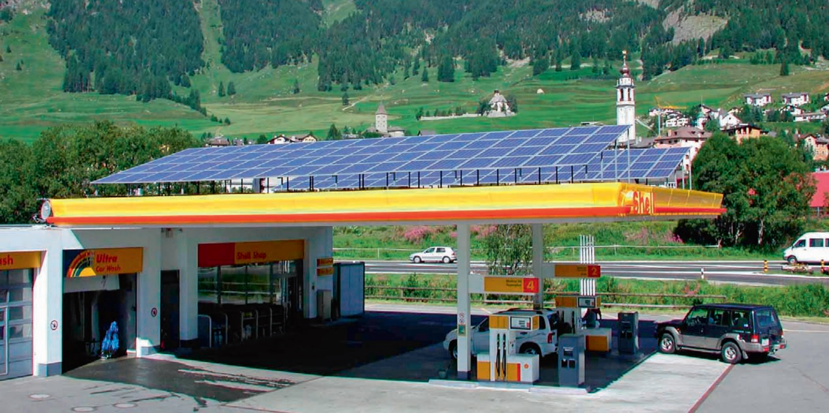
Die SHELL-Photovoltaikanlage Cho d'Punt Samedan wurde im Jahr 2001 gebaut. Dies war die erste PV-Anlage im Engadin im Rahmen der Solarstrombörse des ewz. Installation photovoltaïque SHELL, Cho d'Punt Samedan, 2001. Il s'agit de la première installation PV d'Engadine, dans le cadre de la bourse solaire de l'ewz.
