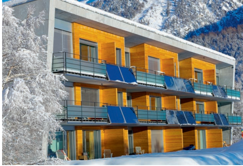
Neubau Quadratscha Samedan. Solarthermie in die Brüstungsgeländer integriert. Architektur Lazzarini AG, Chur-Samedan
