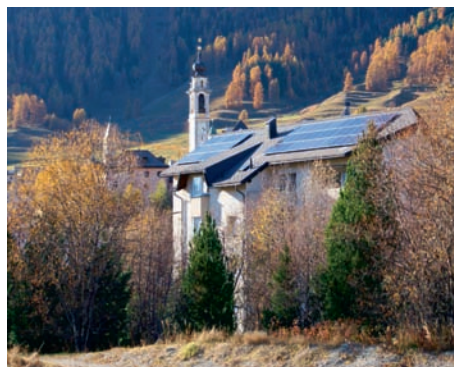
Die Schüco-Solaranlage Suot Staziun, Samedan. Pro Jahr gewinnt sie Strom für fünf bis sechs Haushalte.
