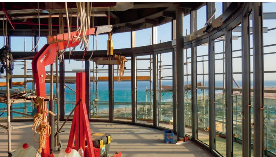
Nach vier Wochen waren die Montagearbeiten abgeschlossen. Quatre semaines de travaux furent nécessaires pour le montage.
