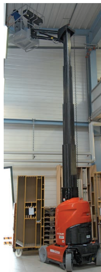
Unterhaltsarbeiten bis zu einer Höhe von 10m mit der Manitou-Vertikalarbeitsbühne 100 VJR.
