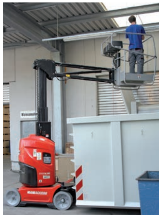
Trotz Hindernis, problemlose Auswechslung der Beleuchtungsröhre.
