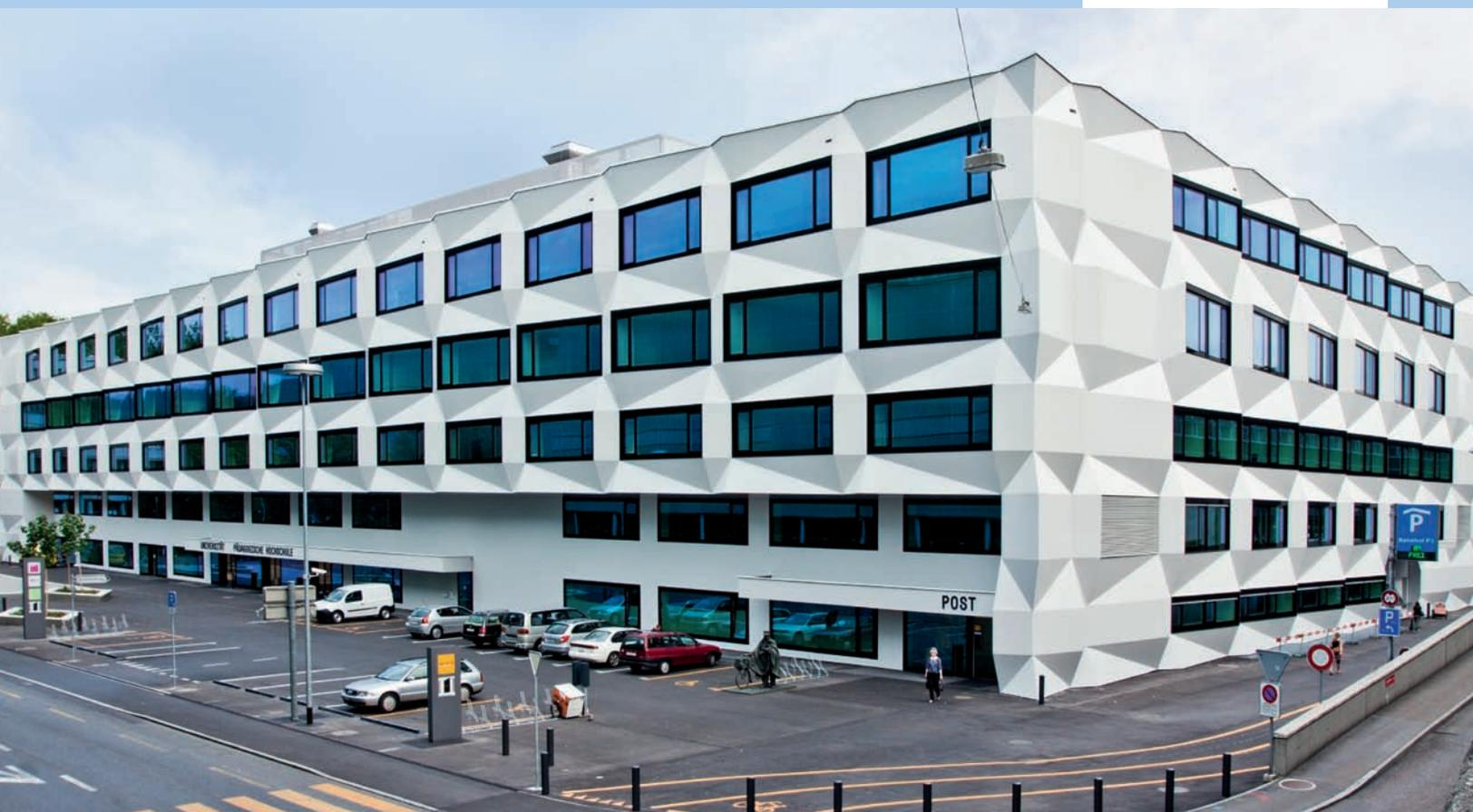
Die Unterkonstruktionen dieser dreidimensionalen Weissputz-Fassade erforderten tausende von unterschiedlichen Profil- und Blechteilen. La structure porteuse de cette façade tridimensionnelle en enduit lisse a nécessité des milliers de profilés et pièces en tôle différents.
