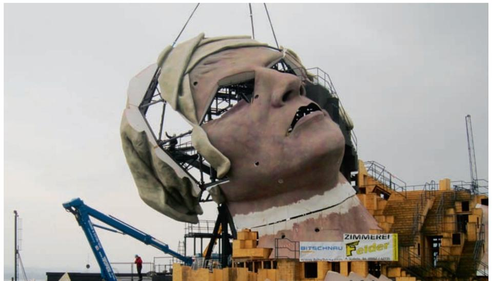
Der Kopf besteht aus einer 17 m langen, 15 m breiten und 15 m hohen Stahlkonstruktion. Für den Transport und die Endmontage wurde der Kopf in drei Teile zerlegt.
