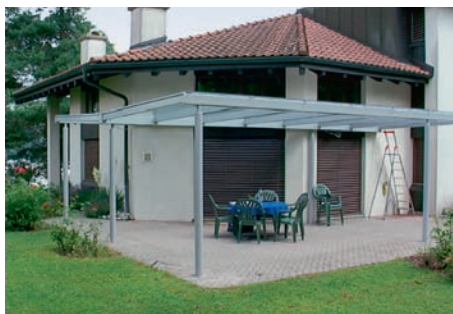
BILD 1: Von einer Überdachung ist zu erwarten, dass diese den Niederschlag aufnimmt und über die vorbestimmten Wege ableitet.
