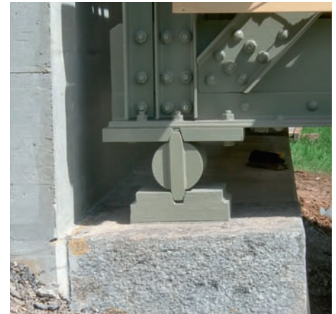
Bewegliche Lagerung auf dem Betonfundament. Appui mobile sur l'assise en béton
