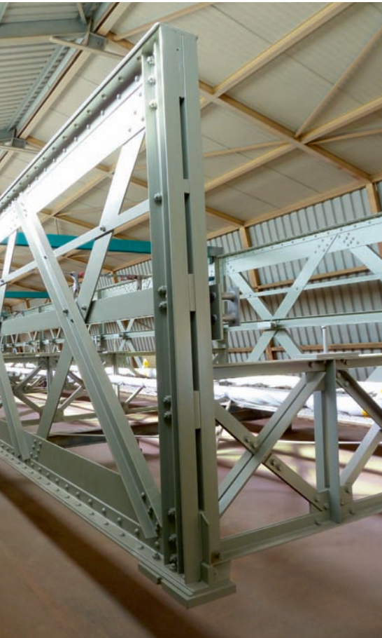
Die Fachwerke mit ihren kreuzweise aneinander gereihten Druck- und Zugstreben zeigen den Kraftverlauf auch optisch auf. Les treillis avec leurs arcs-boutants et tirants entrelacés rendent visible la distribution des forces.
