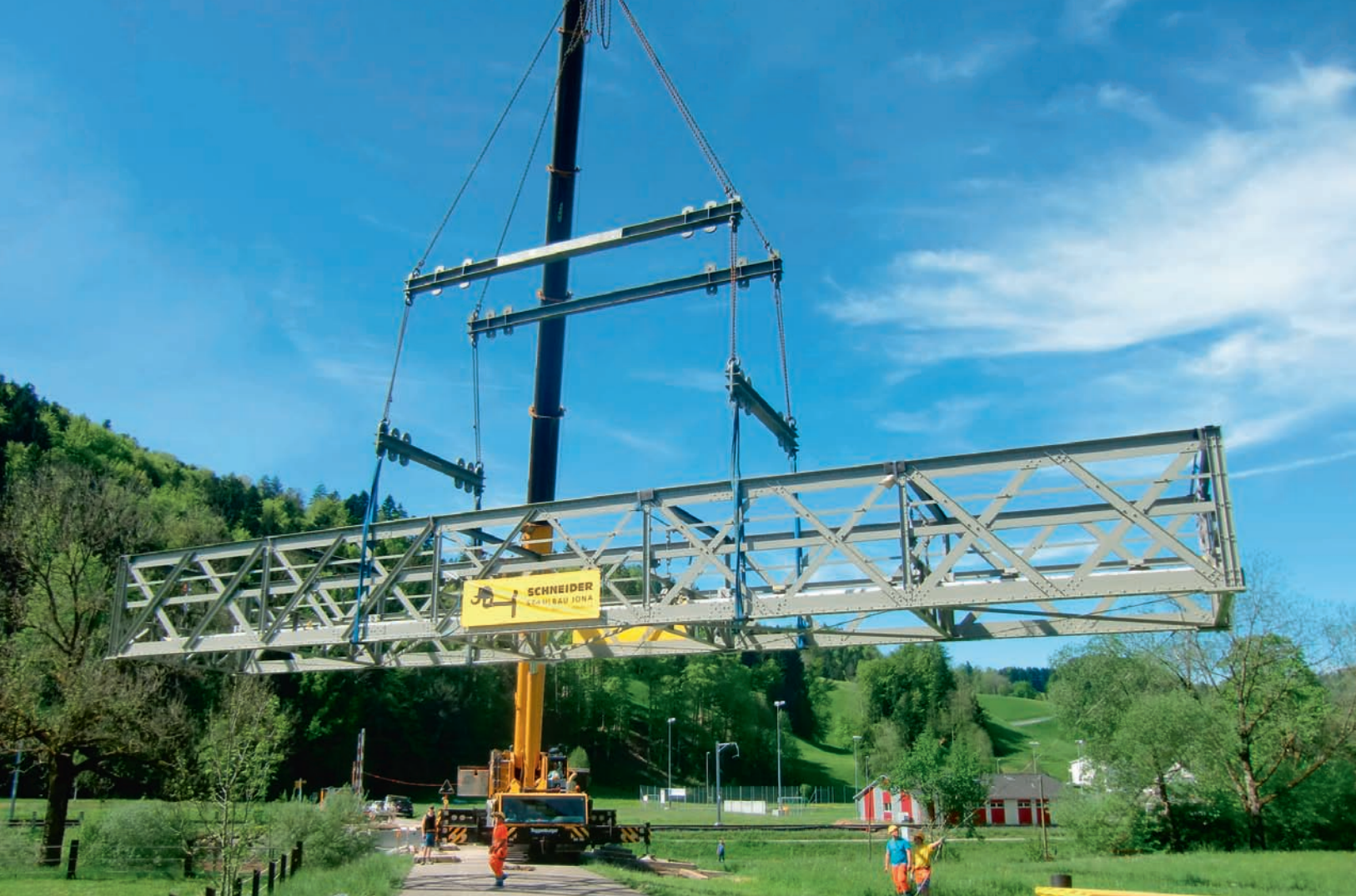
Die sanierte Brücke wird an ihren Zielort gehievt. Le pont rénové est soulevé vers sa destination.
