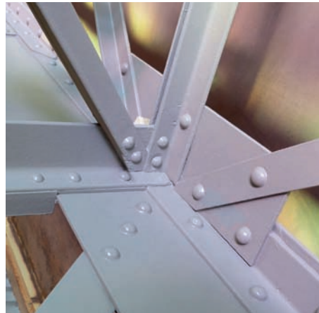
Zentraler Knotenpunkt komplett vernietet. Point de jonction central complètement riveté.
