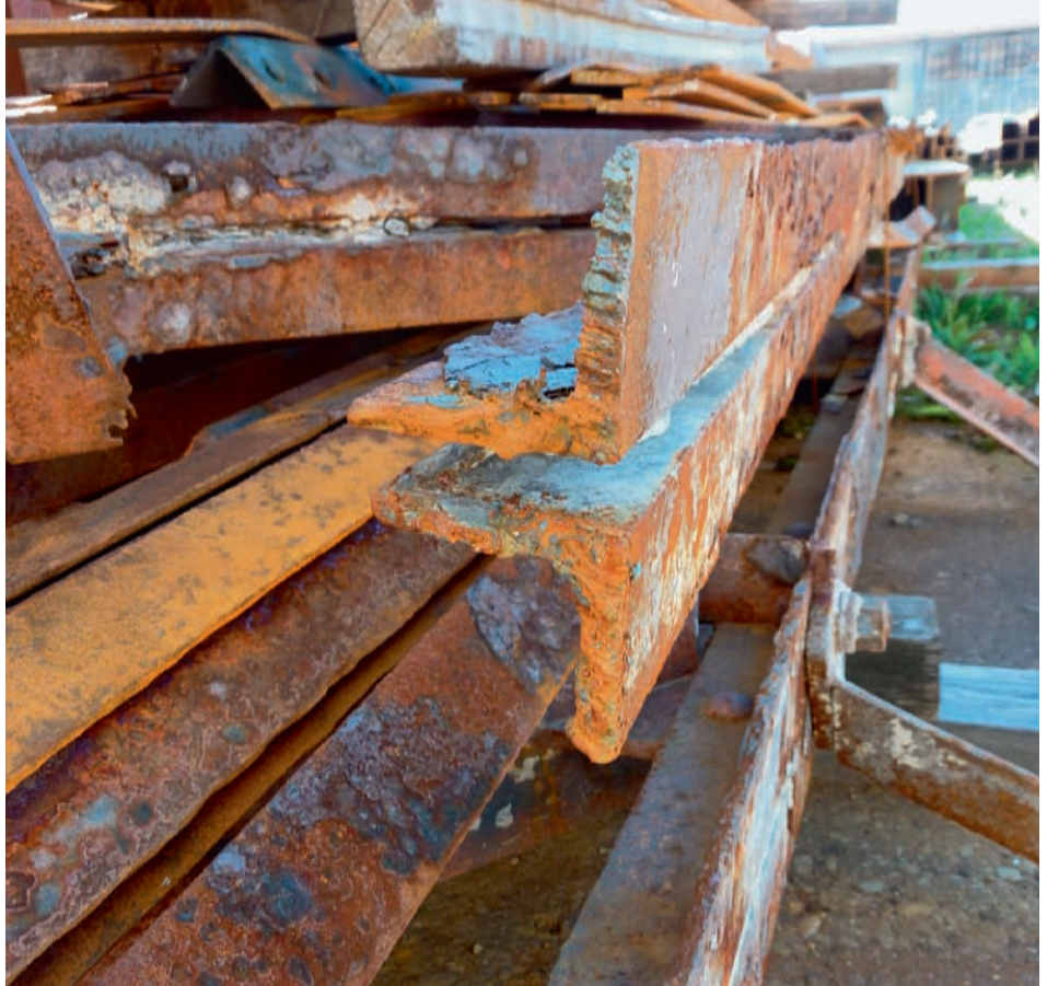
Stark verrostete und von hohem Materialabbau gezeichnete Profile sind durch neue ersetzt worden. Les profilés fortement rouillés et dégradés ont été remplacés par de nouveaux.
