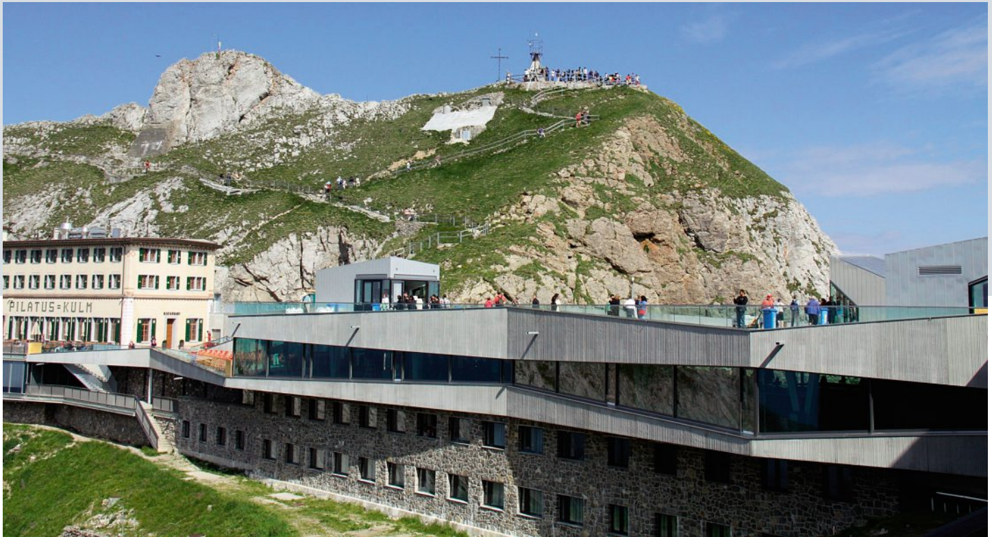
Südseite der Panoramagallerie: Die polygonalen, hochisolierten Verglasungen weisen keinen einzigen rechten Winkel auf. Côté sud de la galerie panoramique : les vitrages polygonaux ultra-isolés ne comportent pas un seul angle droit.
