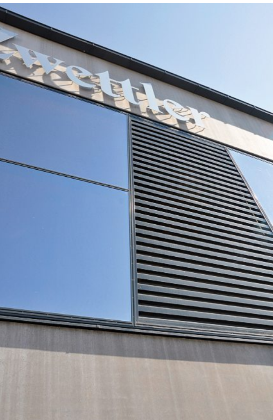
Technisch einwandfreie Übergänge zwischen Glasfassade und Lamellengitter.
