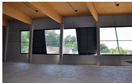
Innenansicht: Bei einem Lüftungsquerschnitt von 35% gewähren die Lamellengitter hohe Schallschutzwerte.
