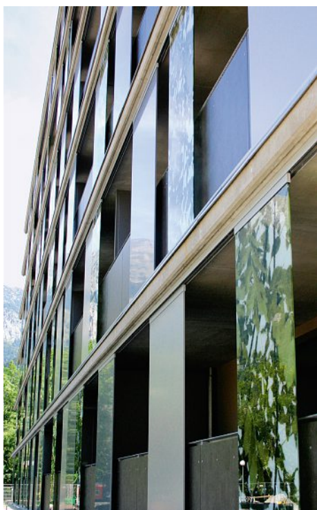
Die Schiebeelemente bestehen teilweise aus Glasplatten, die im Siebverfahren halbttransparent bedruckt sind. Sie laufen vor den Loggia-Brüstungen, in zwei parallelen Schienen hängend.
