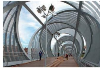
tation zu. Die Brücke ist über 250 Meter lang, der Durchmesser variiert zwischen fünf und zwölf Metern.
