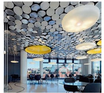
Die Decke besteht aus 4203 im leichten Winkel zueinander abgehängten Ronden aus mikroperforiertem, matt geschliffenem Aluminium, kaschiert auf schallabsorbierendes Trägermaterial. Die natürliche Lichtatmosphäre in der Kantine reagiert damit auf die Umgebung.
