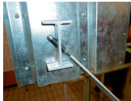
Jede Gruppe hatte ein Detail im Massstab 1:1 zu bauen. Hier eine Zugstangenbefestigung.
