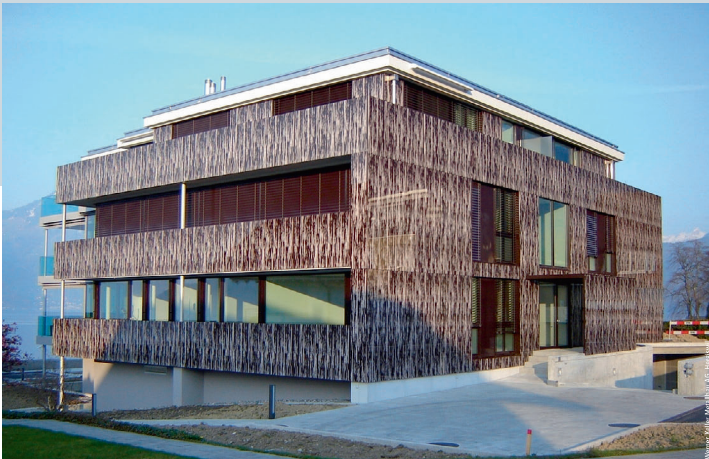
Imposante Wirkung: Einscheibensicherheitsglas vetroDur Design mit Digitaldruck, SSG-verklebt. Effet impressionnant : verre de sécurité trempé vetroDur Design avec impression digitale, collage SSG.
