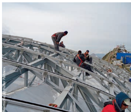
Die aus U-Profilen bestehende Unterkonstruktion ist montiert. Die Bleche können eingesetzt werden.
