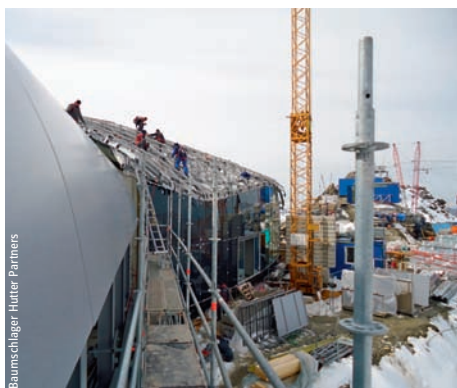
Das dreidimensionale Tragwerk des Daches wird für die Blecheinkleidung vorbereitet.
