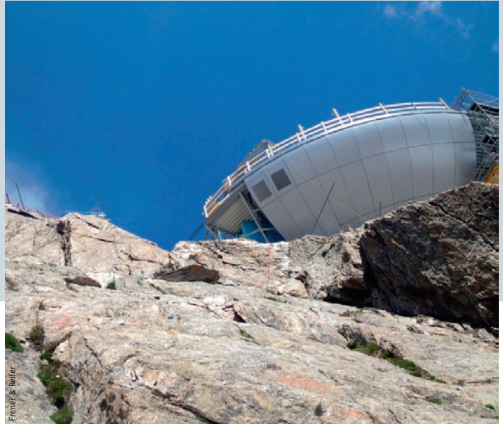
Verkleidung des Terrassentragwerks der Bergstation.
