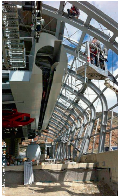
Montage der Unterkonstruktion der Alublechhülle der Talstation.
