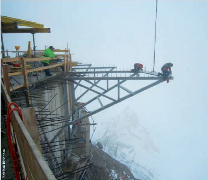
In Schwindel erregender Höhe: Montage der Fachwerkträger der Terrasse der Bergstation.
