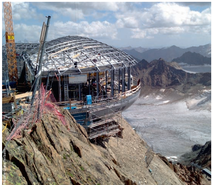
Der Stahlbau ist aufgerichtet: Montage der Unterkonstruktion der Alublechhülle der Bergstation.
