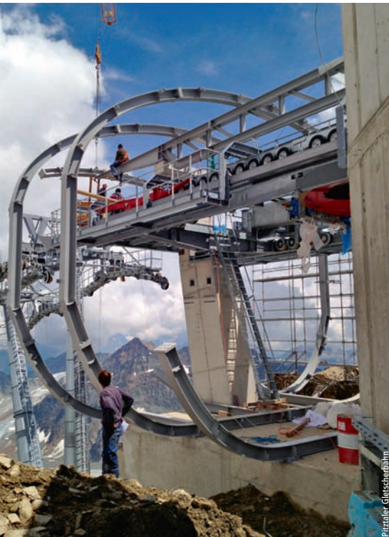
Montage der Stahlkonstruktion in der Einfahrt der Bergstation.
