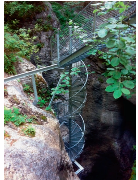
Die Treppe überbrückt zwei Gitterrost-Laufstege in der Adelbodner Cholereenschlucht.
