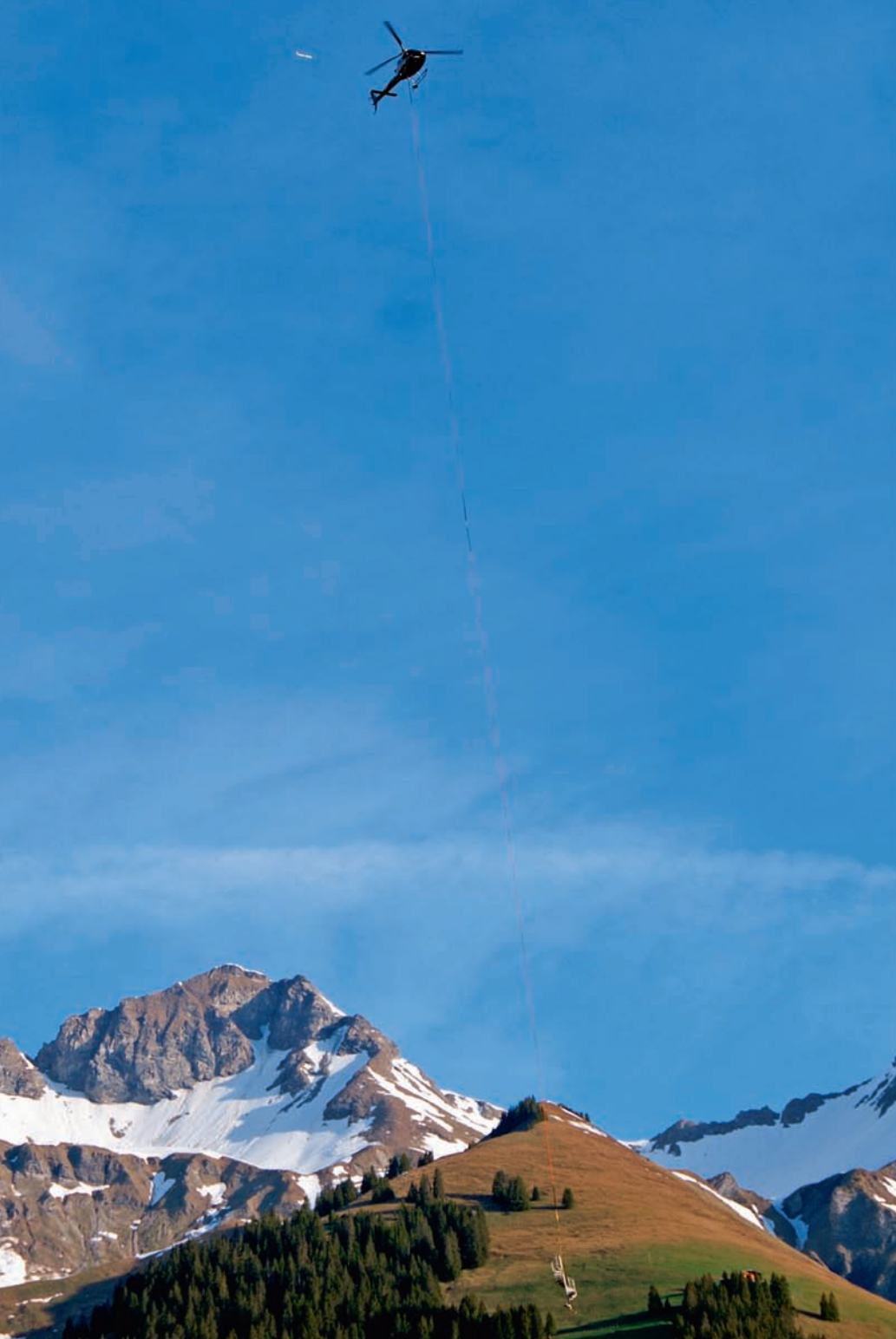
An einem rund 90 m langen Seil hängend kommt die Spindeltreppe angefliegen. Suspendu à une corde de 90 m, l'escalier en colimaçon arrive par les airs.
