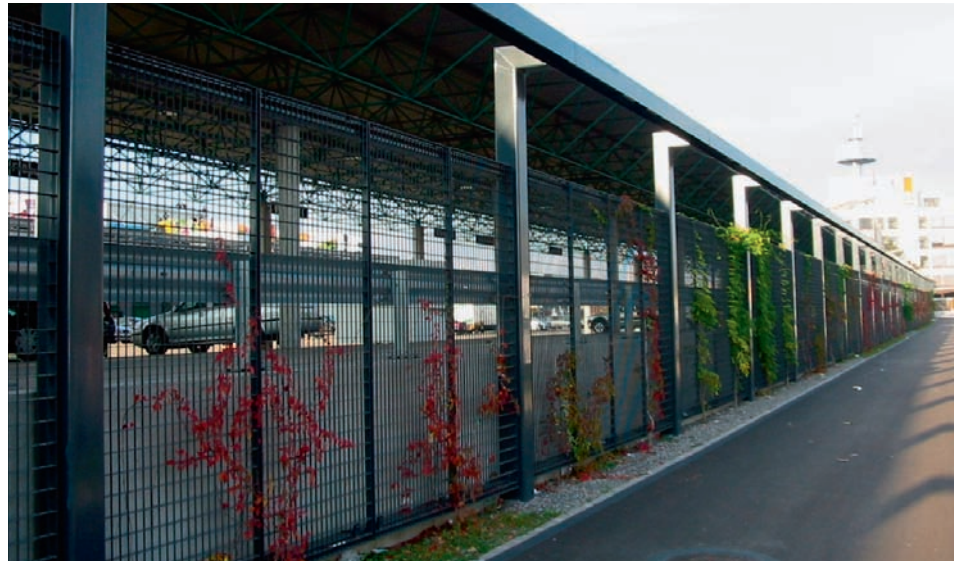
Rund 500 Meter begrüntes Rankgerüst sind an der Pfingstweidstrasse in Zürich erstellt worden.
