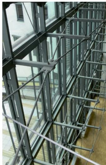
Die Zug- und Druckstabsysteme können im modernen Stahl- und Fassadenbau vielseitig eingesetzt werden.
