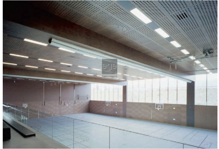
Bild 6: Sicht von der Zuschauerplattform in die unterteilte Dreifachturnhalle. Die technischen Erschliessungen sind unsichtbar über der heruntergehängten Decke verlegt. Photo 6 : Vue du triple gymnase depuis la tribune des spectateurs. Les équipements techniques sont dissimulés dans les faux plafonds.
