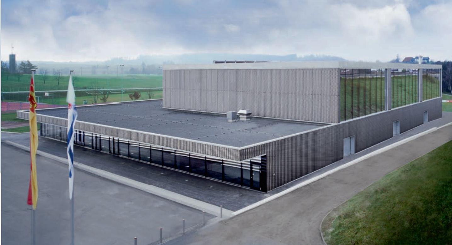
Bild 1: Das rechteckige, 60 m lange und 45 m breite Sportgebäude wird von vier sich optisch unterscheidenden Fassadenbildern geprägt. Links die Ostfassade mit Haupteingang, rechts die Nordfassade.
