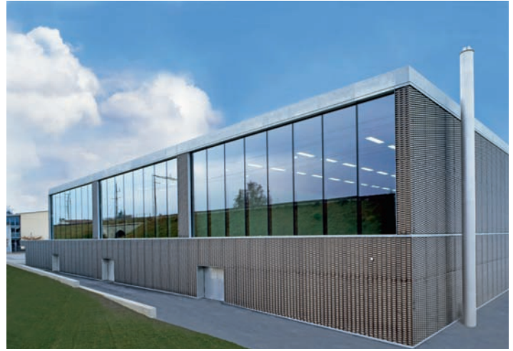
Bild 3: Rechts die komplett mit Streckgitter verkleidete West-Fassade. Ein einzelnes Glas der Nordfassade (links) wiegt über 600 kg.
