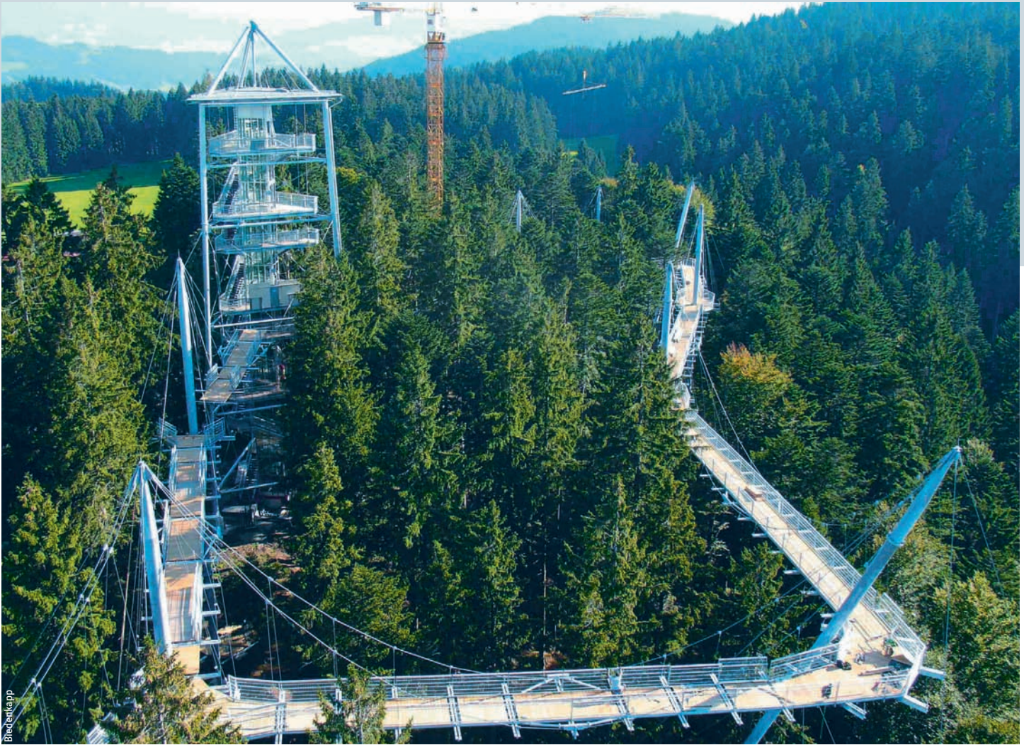
Das Gewinnerobjekt in der Kategorie Stahlkonstruktionen: Der spektakuläre Baumwipfelpfad Skywalk Allgäu der Firma Biedenkapp Stahlbau. Le projet gagnant dans la catégorie Construction en acier : Skywalk Allgäu, le spectaculaire chemin des cimes de l'entreprise Biedenkapp Stahlbau.
