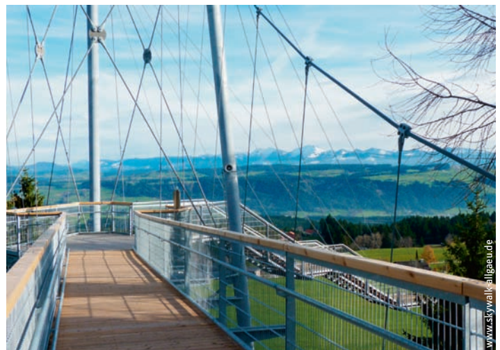
Bei der Konstruktion wurden 500 Tonnen Stahl, 3000 Meter Stahlseil, achtzig Kubikmeter Holz und über 70 000 Schrauben verbaut. La construction a nécessité 500 t d'acier, 3000 m de câbles d'acier, 80 m 3 de bois et plus de 70 000 vis.
