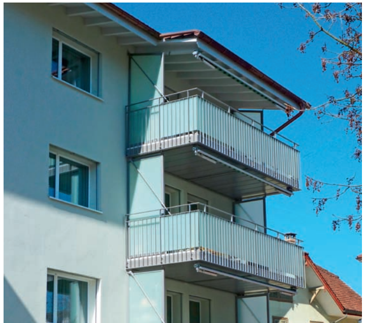
Anhängerbalkon: Die Traglast wird von der jeweiligen oberen Beton-Bodenplatte übernommen. Balcon suspendu : la charge est à chaque fois supportée par la dalle de béton supérieure.
