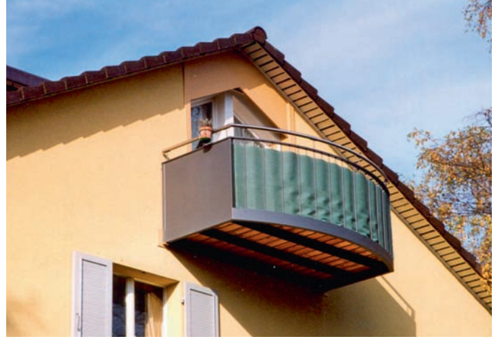
Dieser Anhängerbalkon wird auch über das steif ausgebildete Geländer gehalten. Ce balcon suspendu est aussi maintenu par la balustrade rigide.
