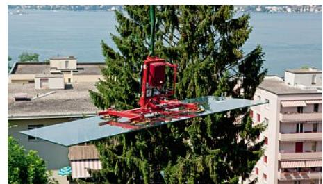
Innert kürzester Frist werden die Dachgläser an den Zielort gehievt, verschraubt und gedichtet.
