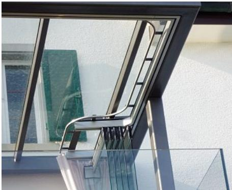
Die örtliche Bodenführung der Ganzglas-Schiebefront muss gewisse Deformationen der Bodenkonstruktion aufnehmen können. Innen der umlaufende textile Vorhang.
