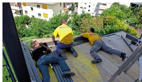
Montage der äusseren Klemmwinkel für die Geländergläser.
