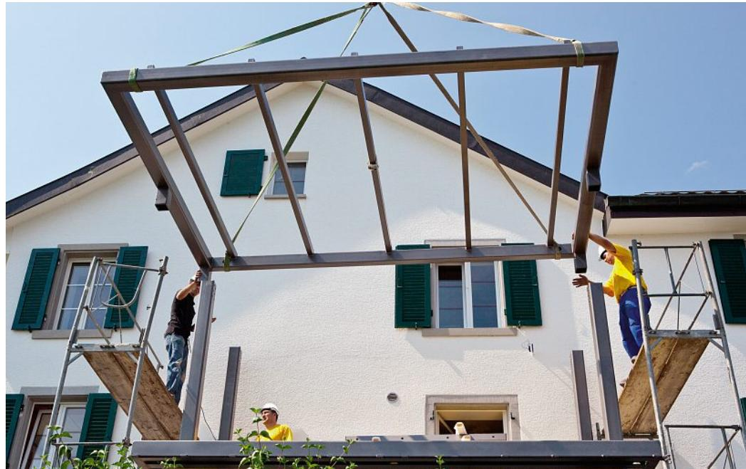
Das Dachgerippe wird als verschweißte Einheit mit dem Kran angeliefert.
