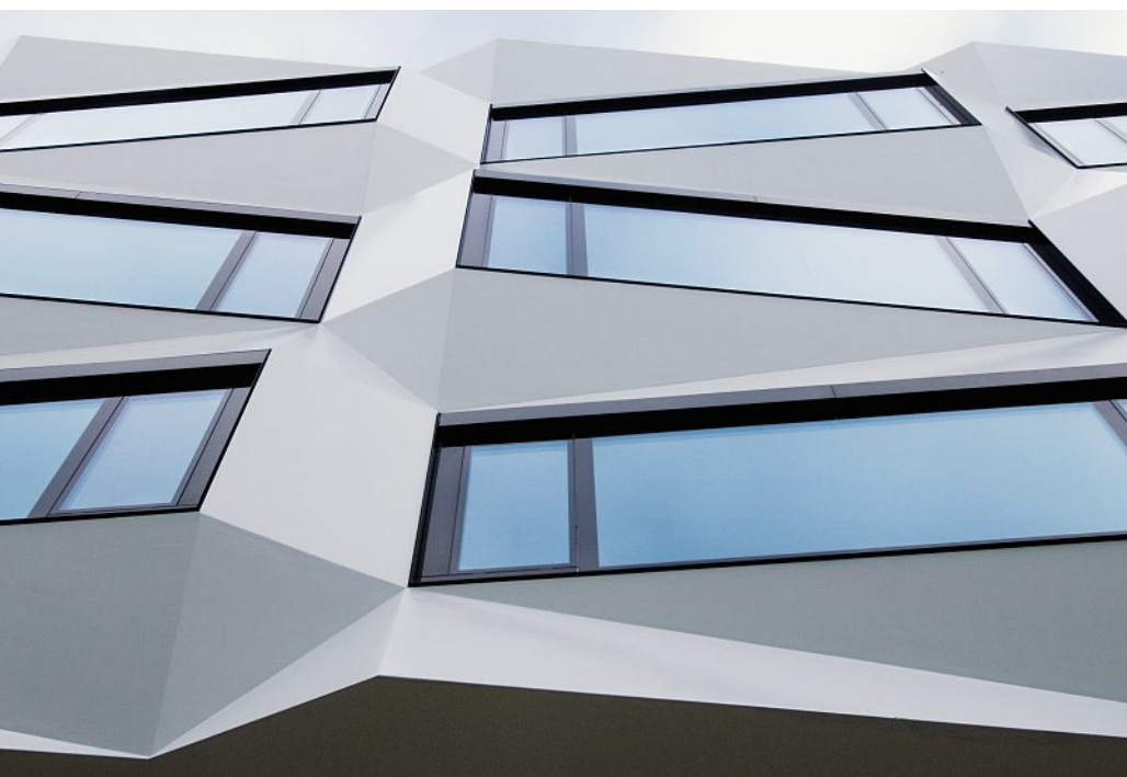
Die Kompaktfassade des Uni-Gebäudes ist modular aufgebaut. La façade compacte du bâtiment universitaire est conçue de manière modulaire.
