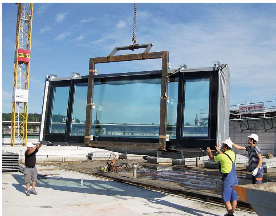
Alle Fenster wurden als Komplettlemente mit umlaufender Grundkonstruktion aus Stahl auf die Baustelle geliefert.
