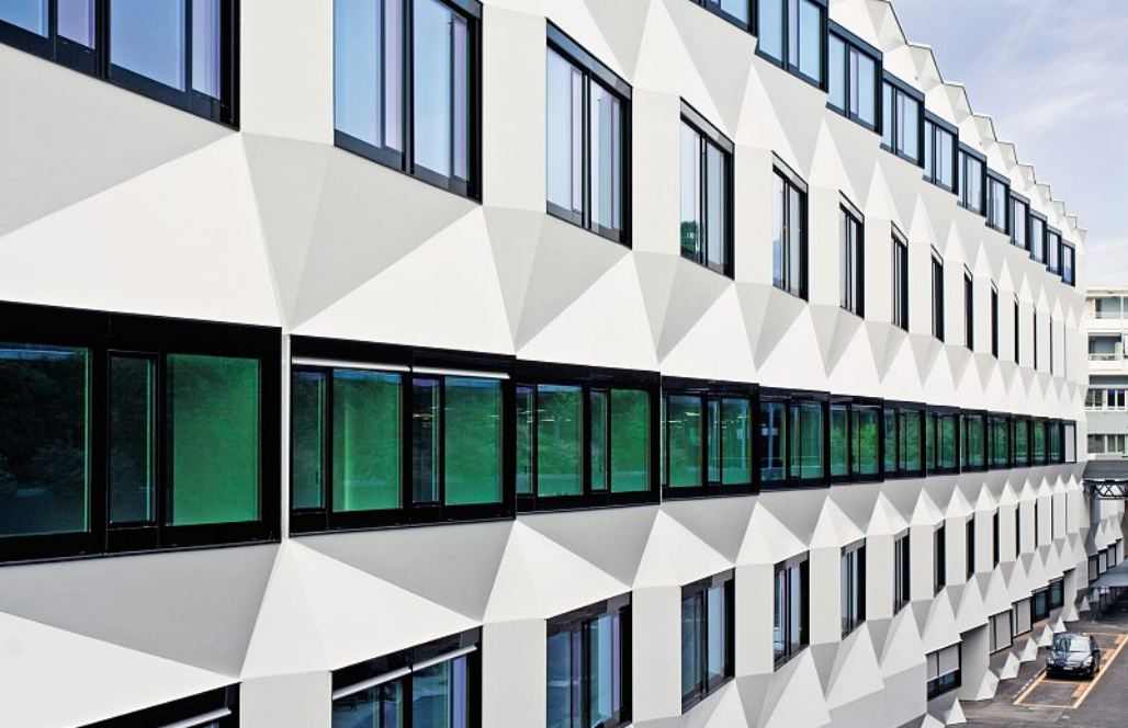
Die fugenlose, dreidimensionale Ausführung der Kompaktfassade und die flächenbündige Integration der Fenster mit Ganzglas-Optik erzeugen eine beeindruckende Homogenität. La réalisation tridimensionnelle sans joints de la façade compacte et l'intégration à fleur avec aspect tout verre créent une homogénéité saisissante.
