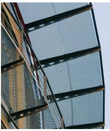
> ein Vollrost erforderlich. Vollroste sind Gitterroste mit gleich hohen Trag- und Querstäben. In einem solchen Fall übernimmt der Querstab die Aufgabe des Sonnenschutzes. Falls erforderlich, werden Gitterroste begehbar dimensioniert, um zum Beispiel einen Zugang für Fenster- und Fassadenreiniger zu erreichen. Des Weiteren sind diese Laufstege in Notsituationen auch als Fluchtweg zu benutzen.
