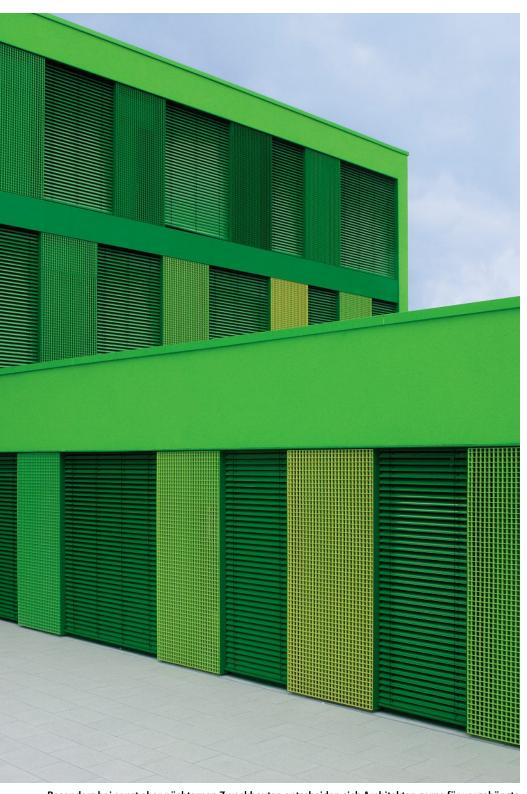
Besonders bei sonst eher nüchternen Zweckbauten entscheiden sich Architekten gerne für vorgehängte Fassaden aus Gitterrosten.
